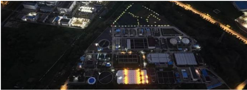
扬州化雨中水回用项目现场
